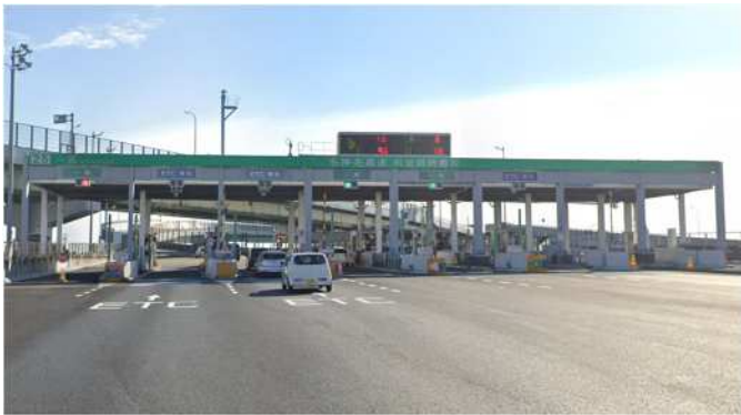
【作業現場写真】
